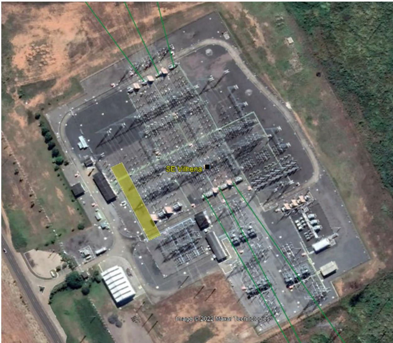
Figura 6-1 – Subestação de Vilhena
