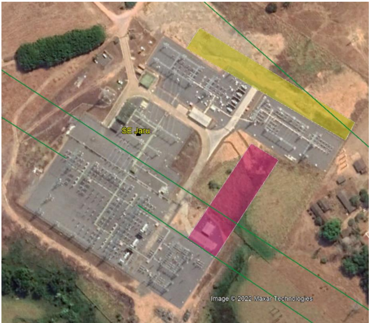
Figura 6-14 – Subestação de Jarú 230/138/69 kV
