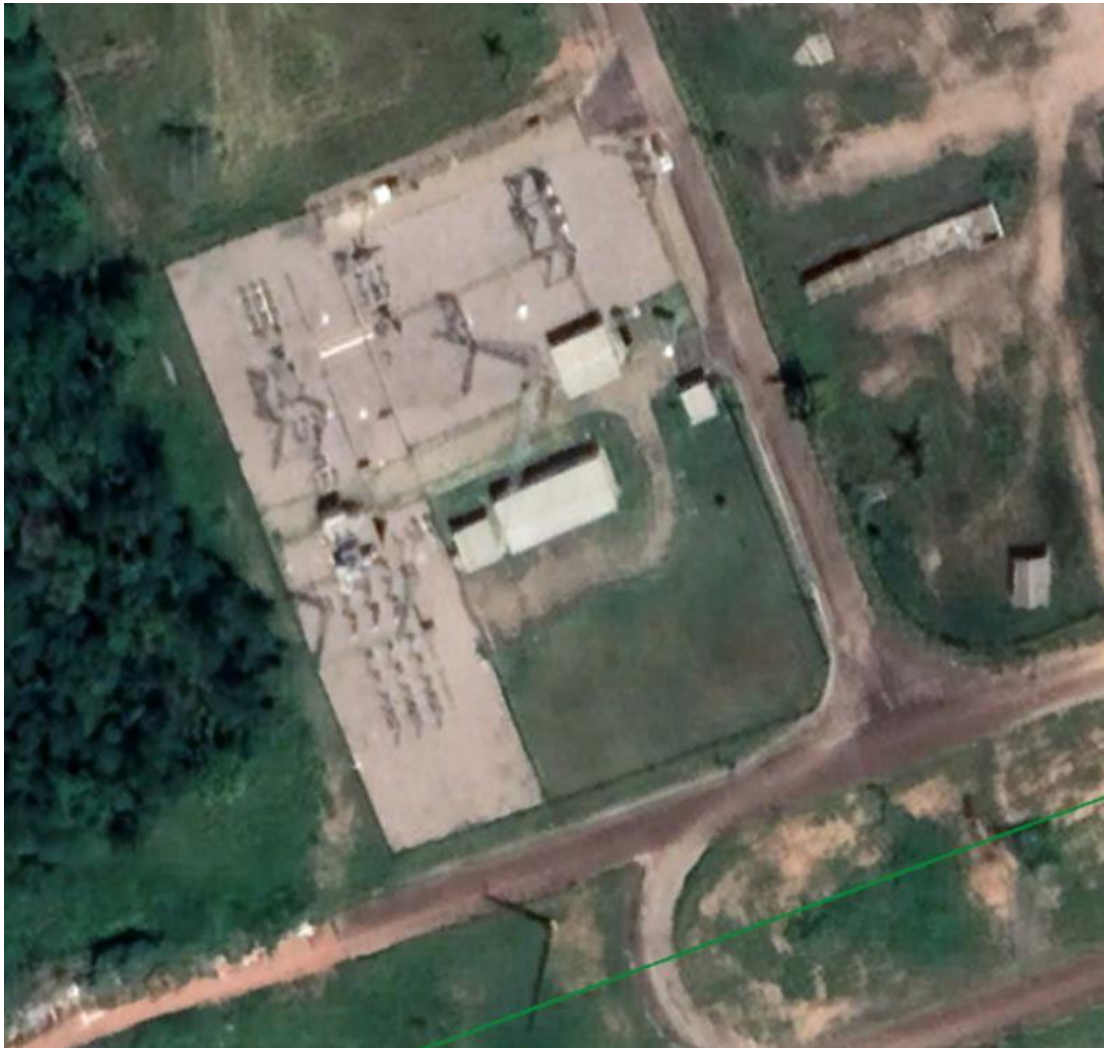
Figura 6-21 – Subestação de Nova Mutum 230/69 kV (provisória)
